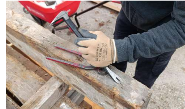
Essais de préparation, Lavoine Charpentiers
