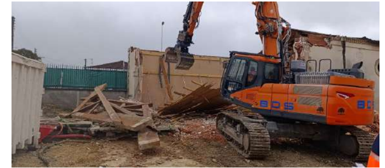
Démolition classique, BDS
