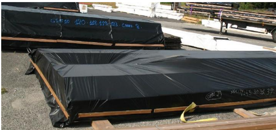
Figure 6 : Exemple de stockage de bois sur chantier - Source Arbonis
